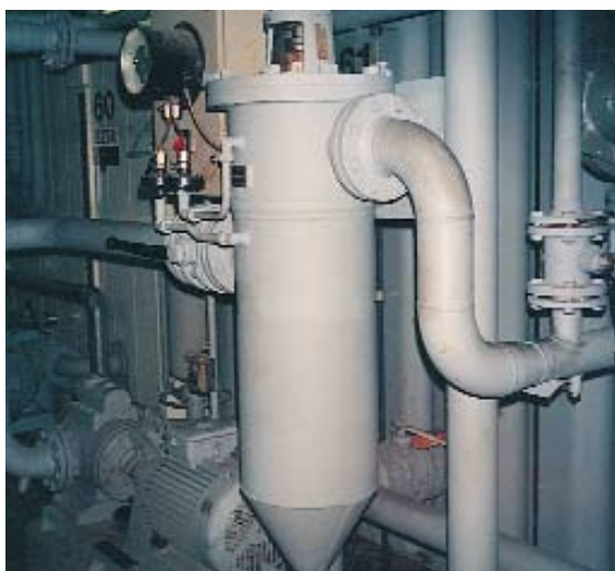
Автоматический кромоочный щелевой фильтр со скребковой очисткой для фильтрации изоцианата (один из компонентов для синтеза полиуретана).
