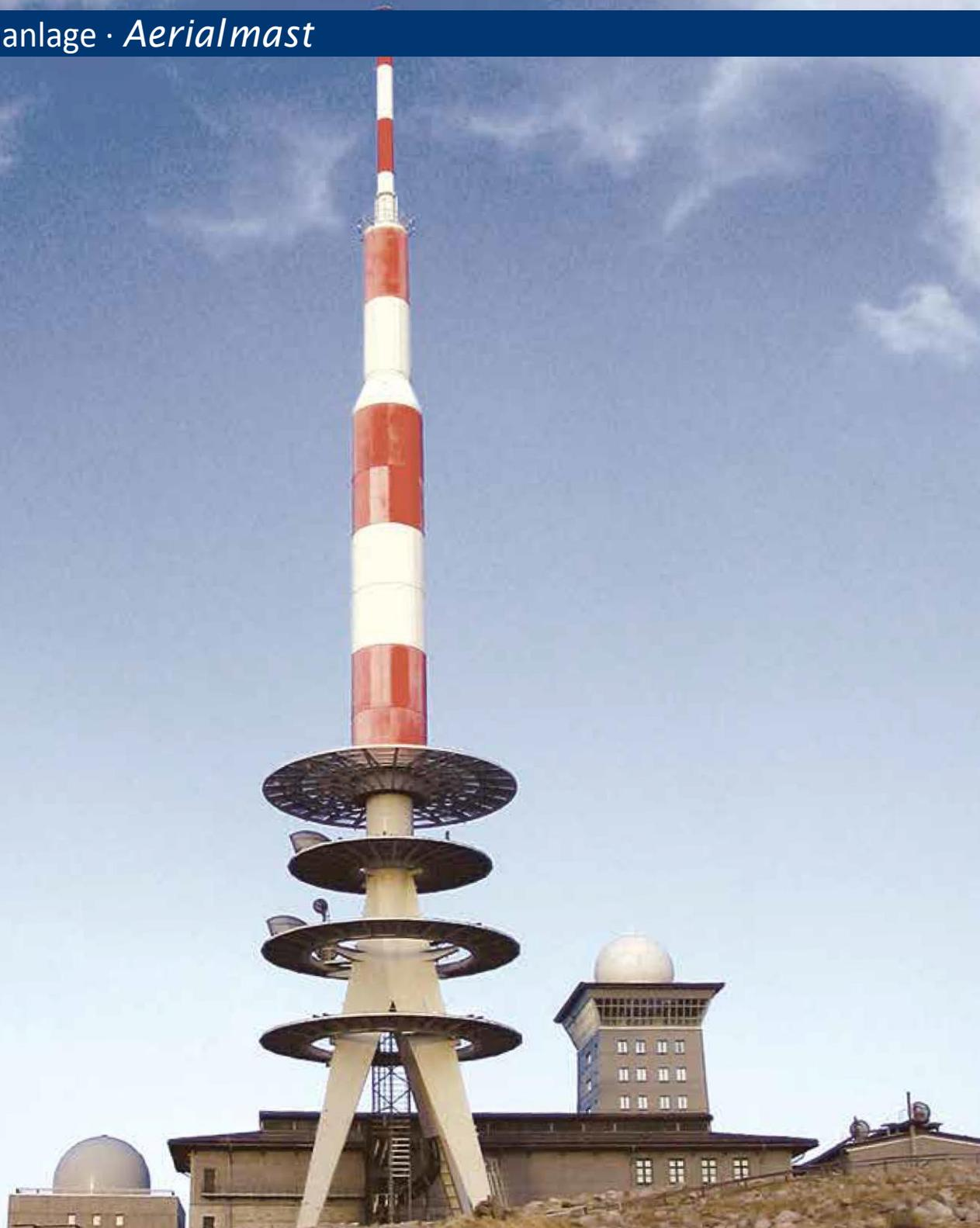
Schlanke Strukturen, wie hier zum Beispiel die Antennenanlage Brocken, können durch Wind zu starken Querschwingungen angeregt werden, die das gesamte Bauwerk gefährden. Abhilfe schaffen RINGFEDER® Schwingungsdämpfer oder -tilger, welche zusammen mit einer pendelnd aufgehängten Masse sicher unter allen Temperaturbedingungen Schornsteine oder Antennen schützen.
